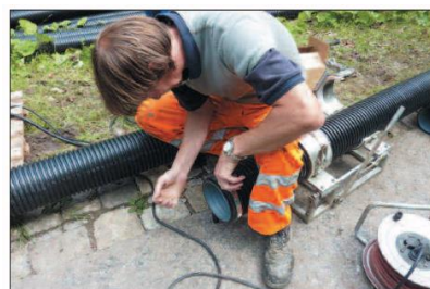
2. Торцовка свариваемых труб посередине гребня волны
